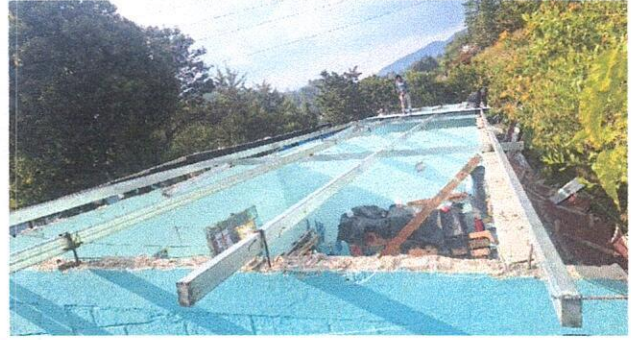
Foto 2: colocacion de costaneras galvanizadas nuevas
