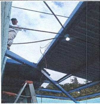
Foto 3: laminas galvanizadas nuevas
