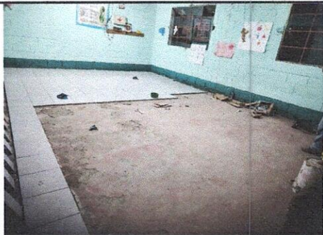
Foto 5: Arreglo de piso en un aula
